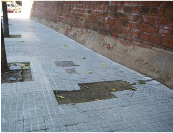
Paviment de vorera en mal estat de conservació
