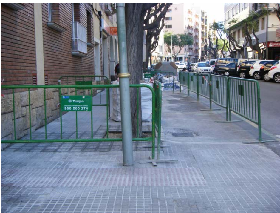
Zona d'obres senyalitzada amb espai reservat per acopi de material però sense previsió de pas per a vianants alternatiu.
