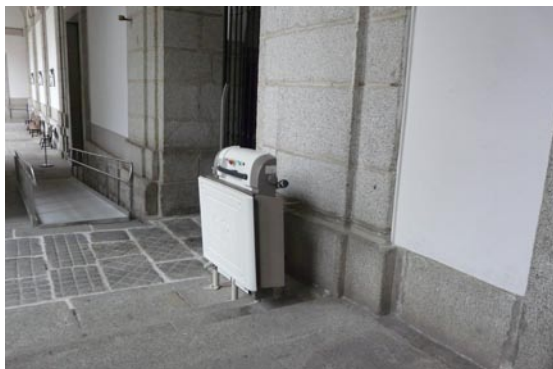
Plataforma elevadora en el Patio del Abrevadero.
