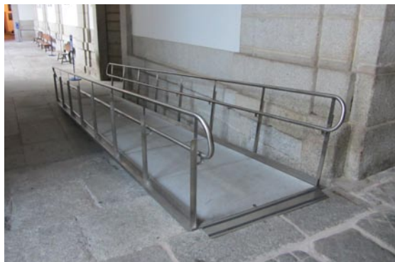
Actuación en el Patio del Abrevadero. Rampa.
