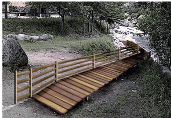
Actuación cerca del puente romano.
