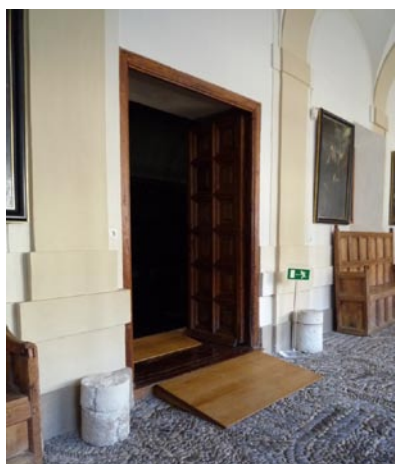
Rampa colocada en el Monasterio de Tordesillas.
