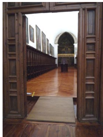
Detalle de rampa movable para permitir el cierre de puertas.
