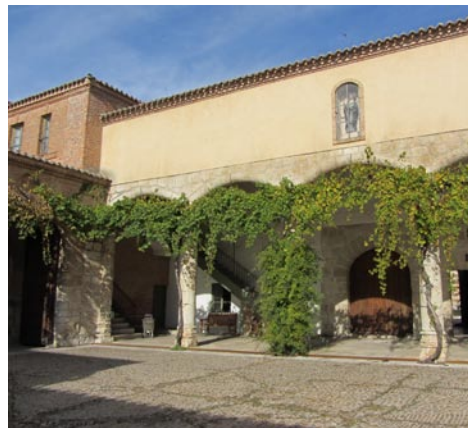
Arquería del compás del convento.
