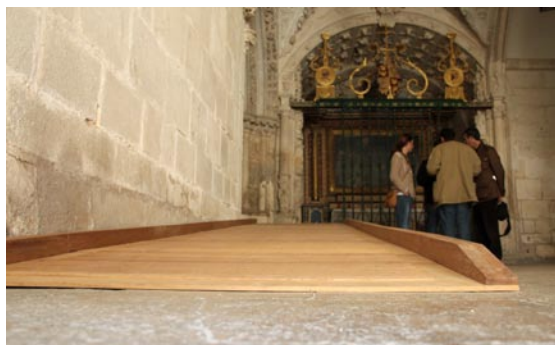
Rampa antideslizante con protección lateral.
