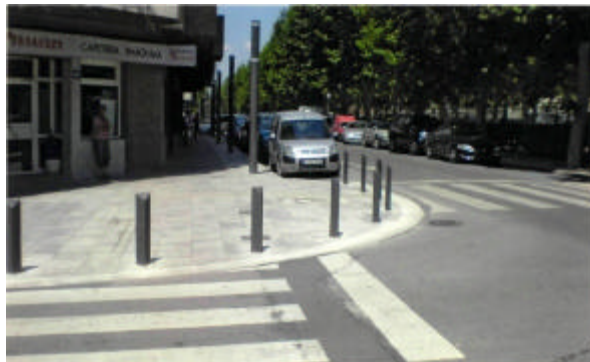
Creación de orejetas en Igualada (Barcelona). Se ha llevado a cabo el rebaje de la acera en todo su contorno para permitir el cruce a nivel de calzada. La dirección del cruce se marca con una banda a base de pavimento estriado.
