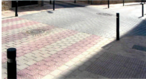
Plataforma única de tráfico mixto (Campo de Criptana, Ciudad Real). Se aprecia la colocación de banda de pavimento contrastado en la zona de tránsito peatonal y a eje con el paso de peatones.
