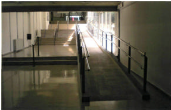
Facultad de Letras, Universidad Autónoma de Barcelona. Escaleras interiores complementadas con rampa que permite la circulación en el edificio. Se aprecia la colocación de pasamanos intermedios en las escaleras así como la instalación de bandas antideslizantes en las huellas de los escalones.
