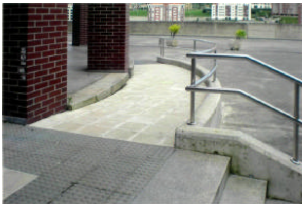
Acceso a la cafetería de la Facultad de Ingeniería Industrial y de Telecomunicaciones, Universidad de Cantabria. Solución integrada para permitir el acceso y la salida del edificio a todos los usuarios.
