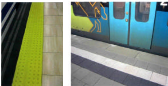
Señalización de borde de andén mediante la utilización de pavimentos tactovisuales que facilitan la detección del mismo a las personas con discapacidad visual.
