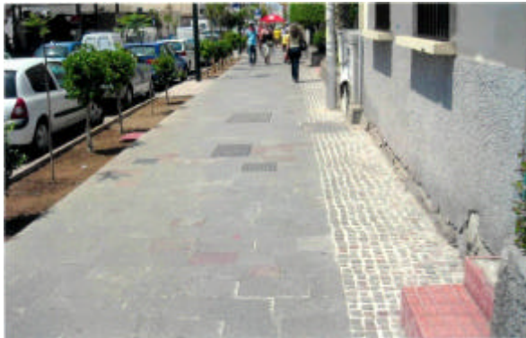
Itinerario peatonal organizado en bandas (Arona, Santa Cruz de Tenerife). Se pueden apreciar claramente las bandas de afección a fachada, la banda libre y la banda de mobiliario.
