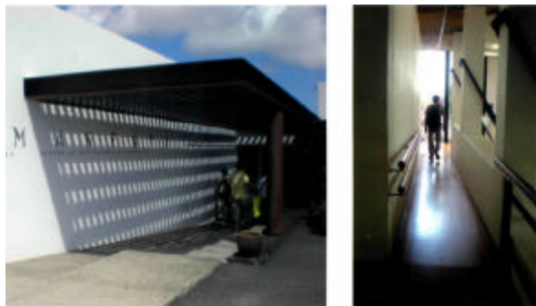
Centro de Visitantes e Interpretación de Mancha Blanca - Parque Nacional de Timanfaya (Las Palmas). Se permite salvar los cambios de nivel en el acceso y el interior del edificio mediante elementos inclinados acorde con la normativa, permitiendo el acceso y desplazamiento a todos los visitantes en condiciones de comodidad y seguridad.
