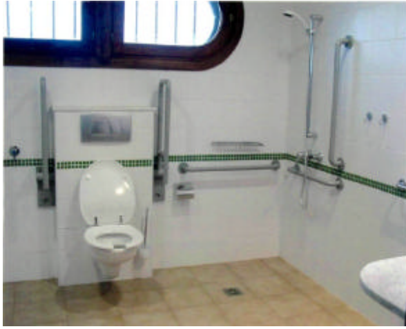
Espacio higiénico adaptado correctamente según parámetros dimensionales y de equipamiento.
