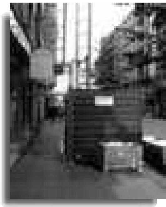
Franja de paso libre junto a la fachada. La zona de trabajos se limita por valla metálica galvanizada (la manguera eléctrica que se ve en el suelo debería ir aérea).
